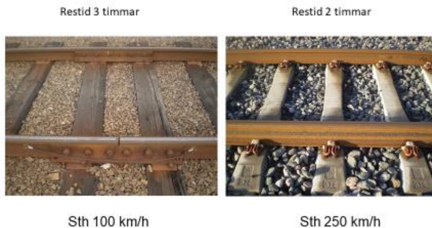
Figur 3. Restiden 3 timmar på grund av skarvspår och 2 timmar i stället med skarvfritt spår.
